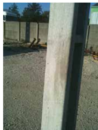
Foto 6 - Poste após intervenção
