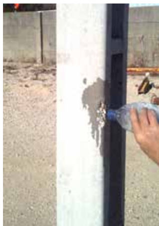
Foto 2 - Salpicar com água o local de reparação
