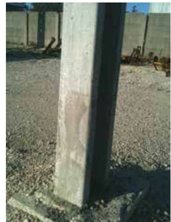
Foto 6 - Poste após intervenção
