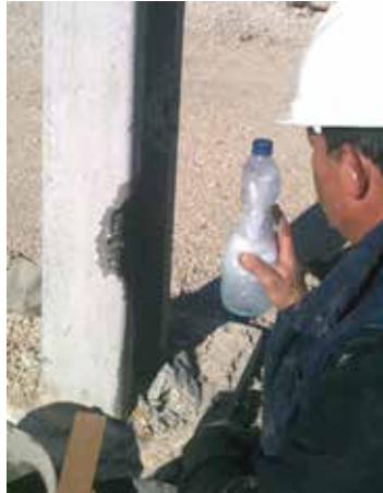
Foto 2 - Salpicar com água o local de reparação
