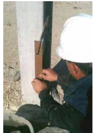
Foto 3 - Colocação da cofragem e aplicação de massa grossa
