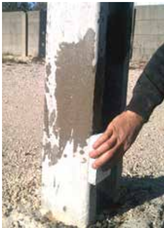
Foto 5 - Acabamento final após aplicação de massa fina
